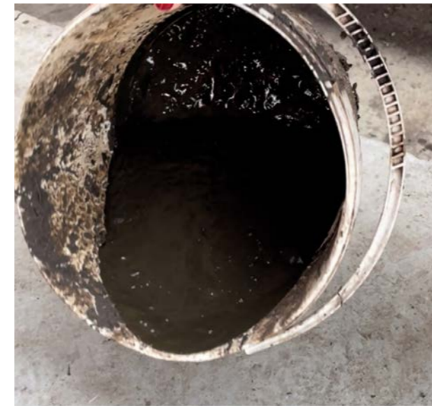
"Purea" ingestato, ingresso Reattori Ingested "puree", reactor inlet
